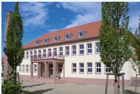
Gebäude bilinguale Grundschule
