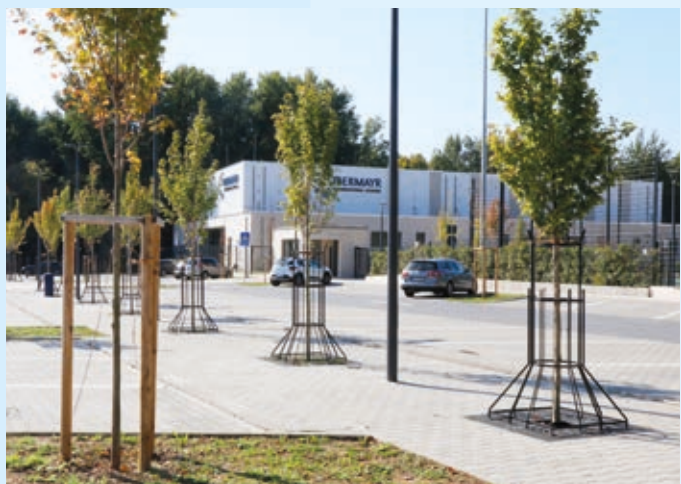
Sporthalle International School mit Parkplatz
