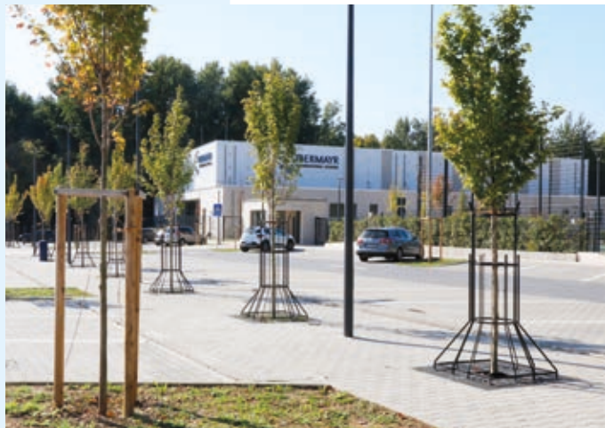
Sporthalle International School mit Parkplatz
